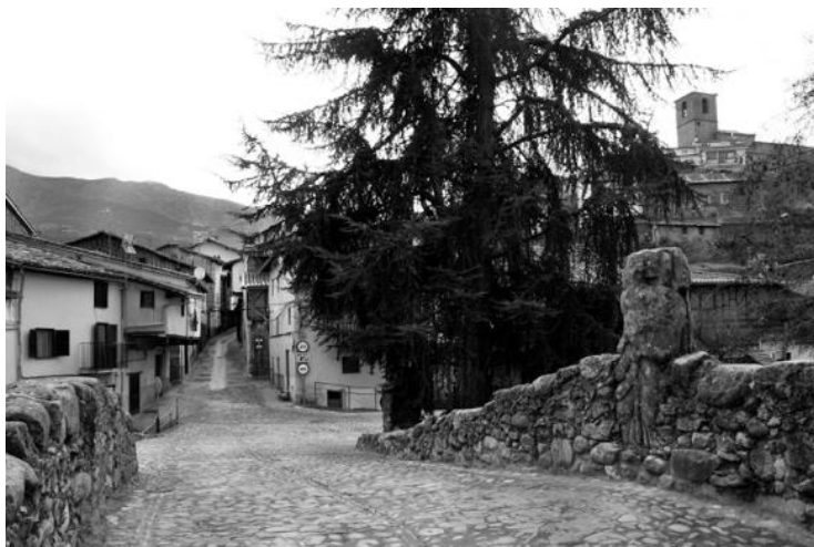
El puente del Mediano, la figura de Alonso Sánchez y la calle del Puente, entrada a Hervás hasta el siglo XIX
